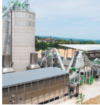
Das Pelletswerk in Hardeggen ist eines von elf Standorten der EC Bioenergie-Gruppe.
